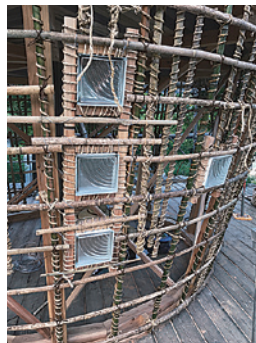
◀組み上がった竹小舞。採光 にはガラスブロックを使用。
